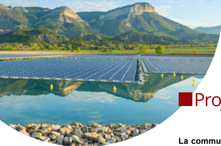
Exemple de centrale solaire à Lazer (05)
