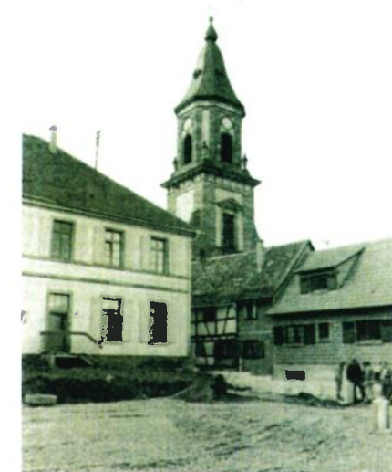
Travaux dans la cour de la mairie en 1986.
