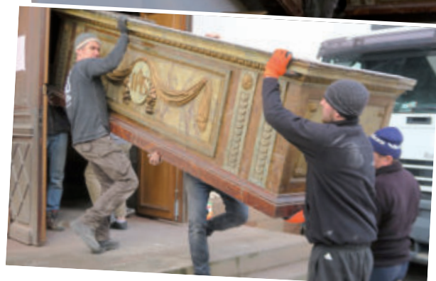
Démontage des autels latéraux
